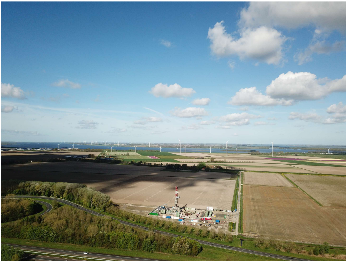
De SCAN onderzoeksboring in Heijningen in 2024
