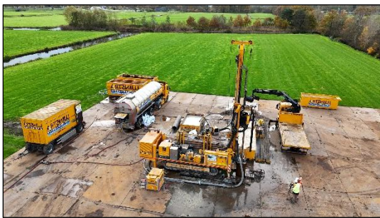
Figuur 7 Met een grondboormachine wordt het gat geboord waarna de conductor in het geboorde gat wordt aangebracht (Foto's: EBN B.V.)
