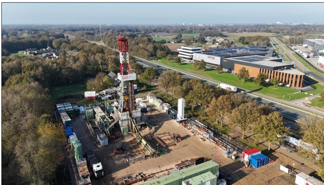
Figuur 9 Een boortoren waarmee de putten worden aangelegd (Foto: EBN B.V.)
