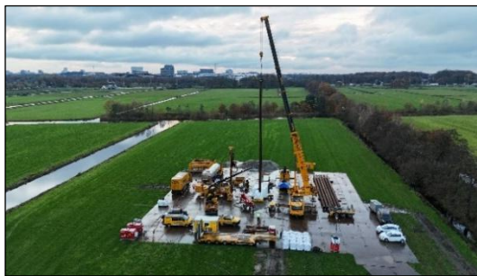
Figuur 7 Met een grondboormachine wordt het gat geboord waarna de conductor in het geboorde gat wordt aangebracht (Foto's: EBN B.V.)
