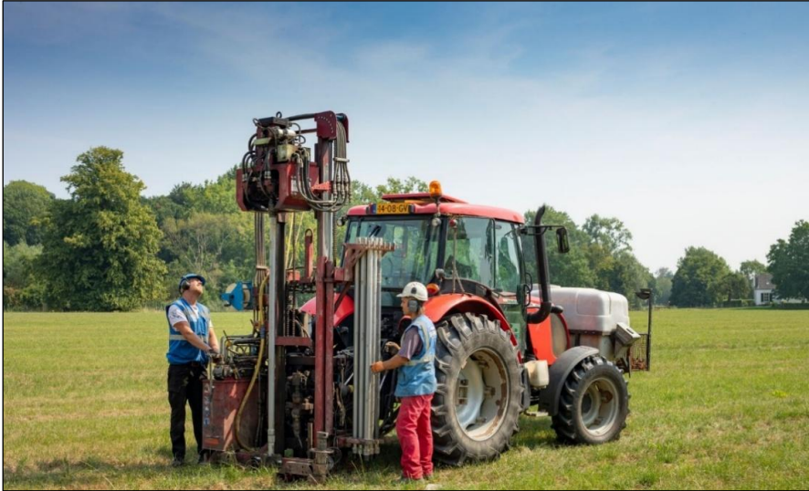
Figuur 3 Een mobiele boorinstallatie gebruikt voor het boren van een 10-40 meter diep gat met de diameter van een steigerbuis (Bron: EBN B.V.)
