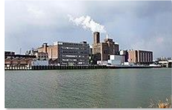
Restwarmte – industriële processen
