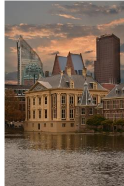
Den Haag: 1e project gebouwde omgeving NL
