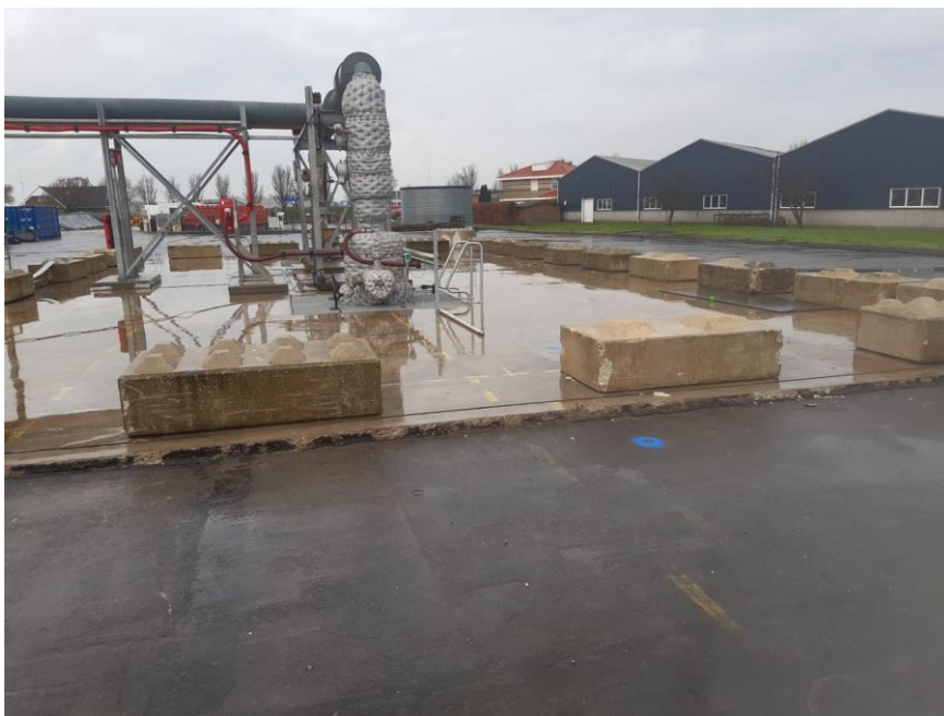
Figuur 3: Geothermische productieput NLW-GT-02 met op de achtergrond injectieput NLW-GT-01. Beide putten zijn omgeven door betonplaat en via bovenhoofdse buizen verbonden met de warmtewisselaar.
