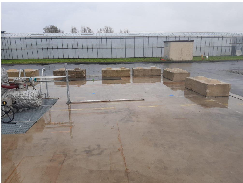
Figuur 8: Locaties van de voorgestelde sonderingen met DTS kabel bij boring NLW-GT-02 (links deel van de well head en putkelder). De geplande locaties zijn met blauwe stippen op de betonplaat aangegeven.
